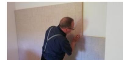
Feinjustierung: Ecken genau ausrichten
